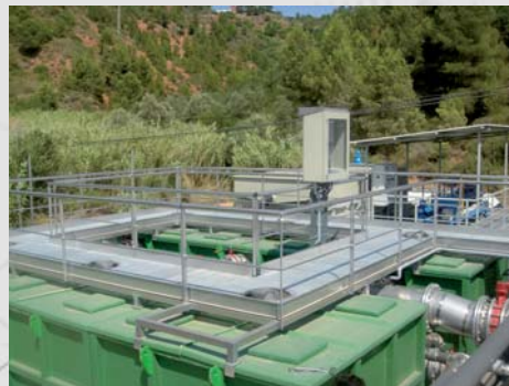
Col·laboració projecte executiu i direcció d'obra planta de tractament d'aigua potable
