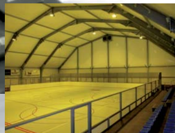
Projecte executiu i direcció d'obra d'una pista poliesportiva coberta a Castellbisbal.
