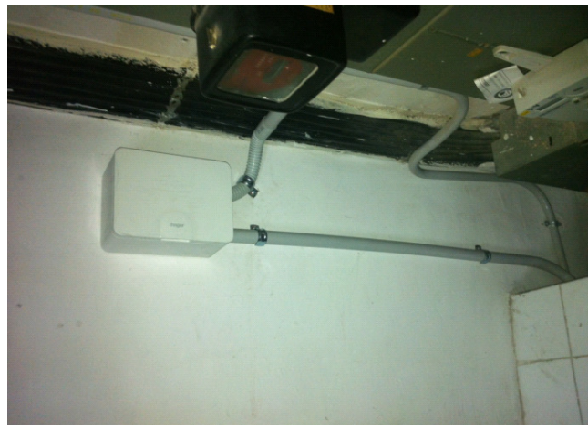
Proteccion de la Linea Recarga del V.E. , Automatico y un Prot. Sobretensiones Combinado
